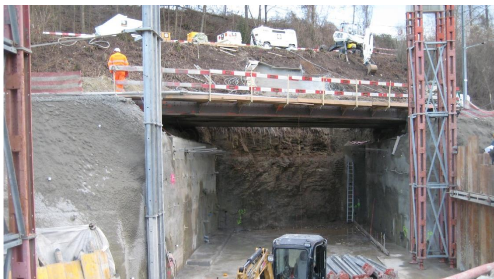
Abbildung 5.7: Beispiel Unterquerung Bahnlinie mit einer Hilfsbrücke und Sicherung vertikaler Baugrubenwände (HWS Lyssbach)
